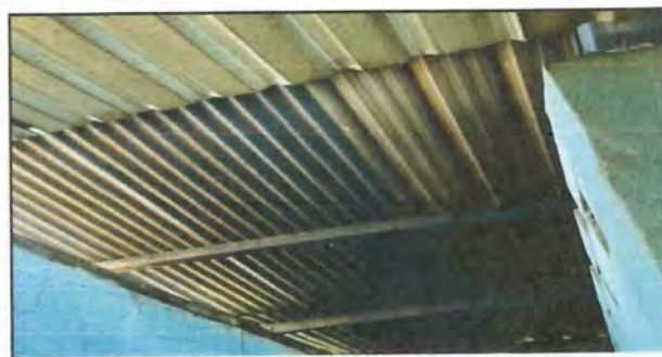
Foto 10: CAMBIO DE COSTANERA DE MADERA POR COSTANERA DE METAL
