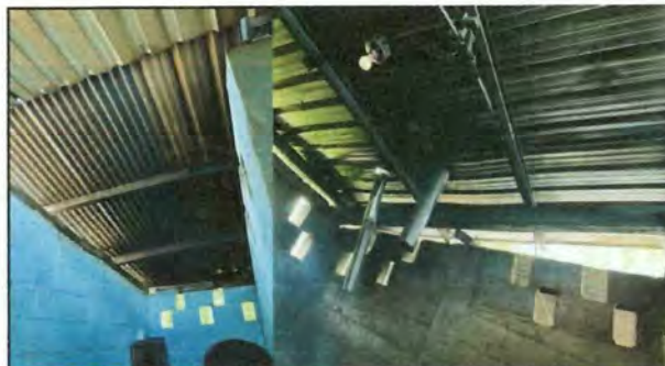
Foto 4: CAMBIO DE LAMINAS DETERIORADAS EN COCINA Y MEJORAMIENTO DE SISTEMA ELECTRICO
