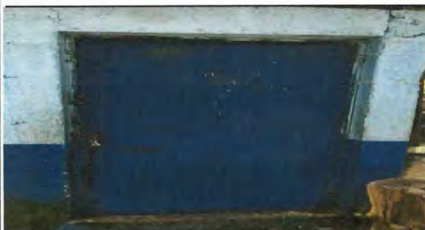
Foto 3: SUSTITUCION DE PUERTA DE COCINA
