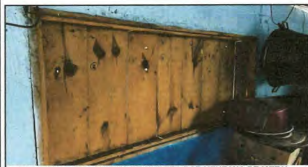
Foto 5: CAMBIO DE VENTANA DE MADERA POR VENTANA DE METAL PARTE DE ENFRETE DE LA COCINA.
