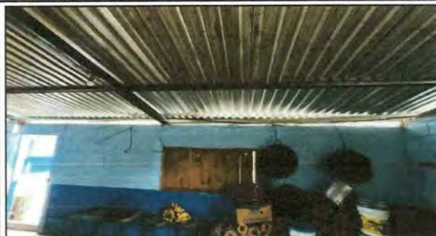
Foto1: ELEVACION DE MURO DE COCINA Y MEJORAMIENTO DE SISTEMA ELECTRICO EN COCINA Y CORREDOR
