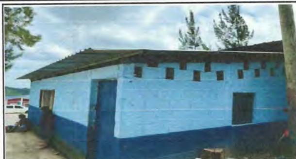
Foto 7: INSTALACION DE CANAL PARA COCINA ENFRENTY Y ATRAS
